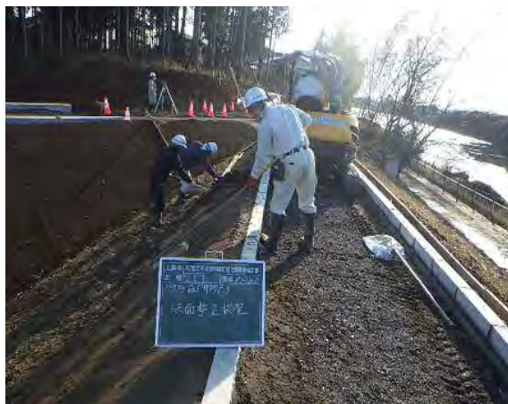
築堤および法面整形
