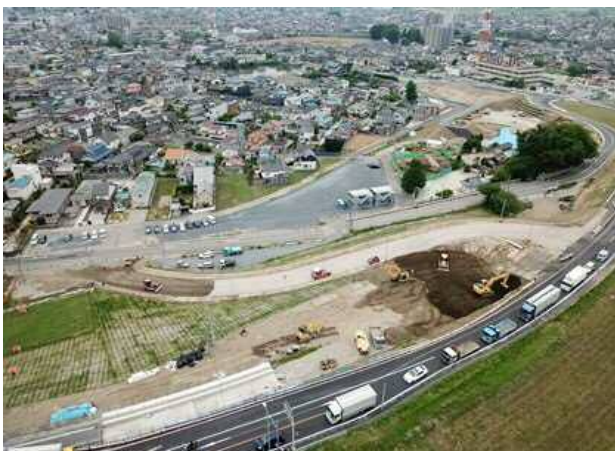
築堤盛土及び道路付け替え施工状況
